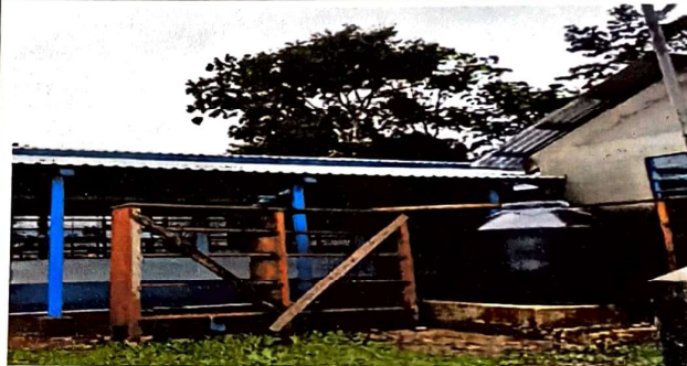
Foto 2: parte frontal terminada
