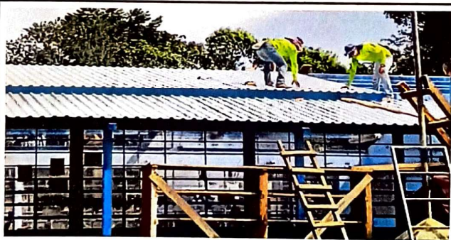
Foto 3: culminando entechado frontal
